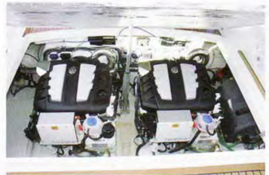
Saubere Installation der 230 PS-Dieselbo-liden.
